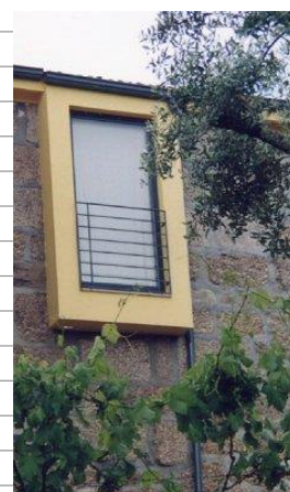
Remodelação de casa rural
